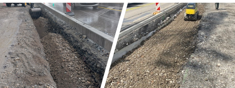
Chronovélo - Pont de claix
